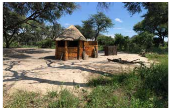
Bau des Eco-Gemeinde Campingplatzes
